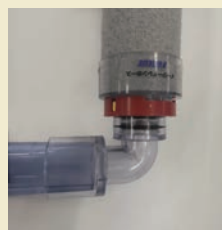
硬質塩ビ継手 (接着接続方式)
