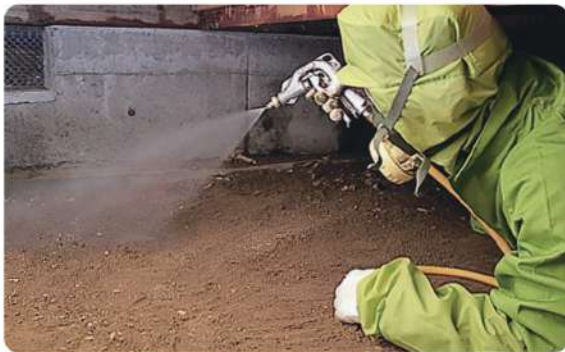
土壌散布処理
