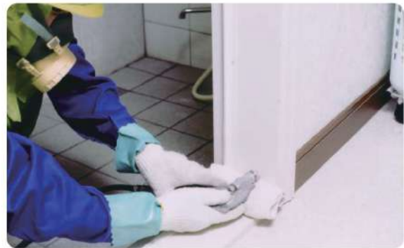
穿孔注入処理
